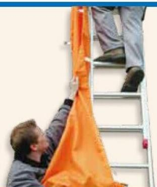
“ FAERYDUCT®法瑞管具有抗菌杀菌两种材质，不会产生霉菌。法瑞管通过了世界上最严格的 OEKO-TEX100 认证，同时在中国也通过了中国纺织科学院和广州疾控中心的检测，霉菌杀死率  $\geq 99.99\%$ 。 ”
