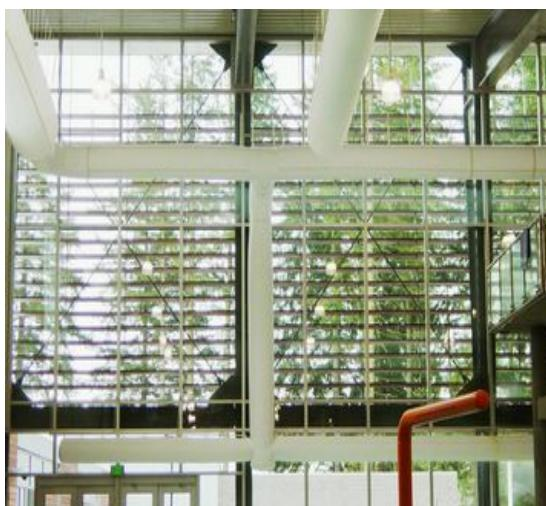
鲜空气的要求，更多的人把目光转移到健康上。法瑞健康风系统是一个从风机出口到末端织物空气分布器的模块化技术，根据建筑环境需要和用户个性化需求的不同，通过模块的加减组合，提供并保证室内的绿色空气及健康呼吸。
