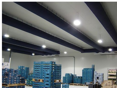
药品冷库及阴凉库法瑞空气分布器低温送风案例
