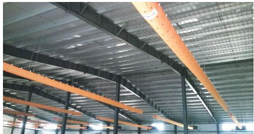
气分布器外的湿空气无法接触管壁，故 FaeryDuct 法瑞管表面不会产生结露现象，国内仿照者因为无法准确设计渗透率，会造成管壁结露。
