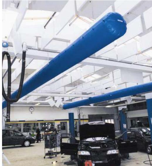
管采用渗透性的材料不会凝露，省去了保温材料，质量仅为传统风管的 1/40，对结构影响小，可以放在网架中。
